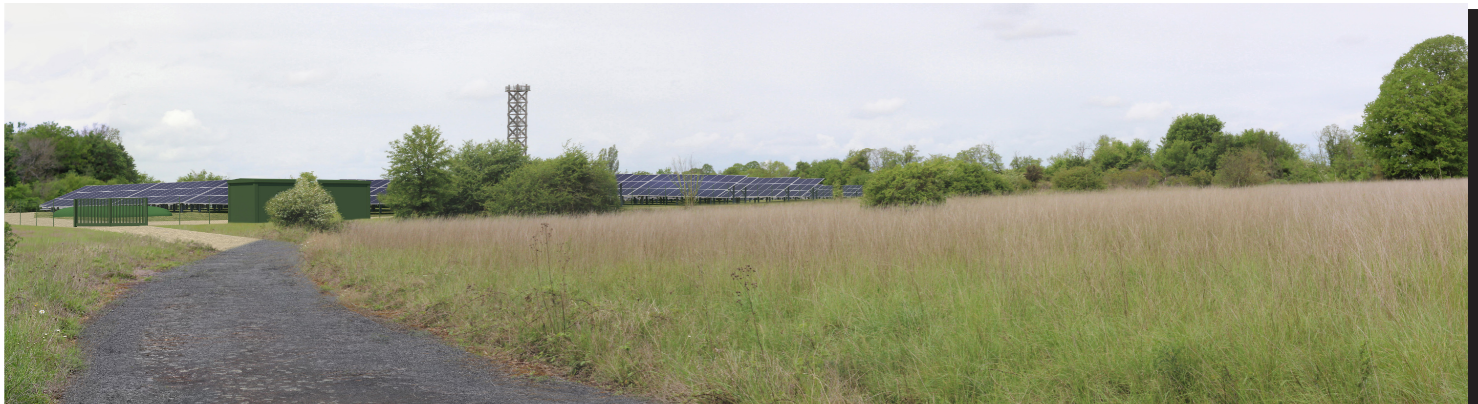
VUE 1 - Insertion avec mesures paysagères
